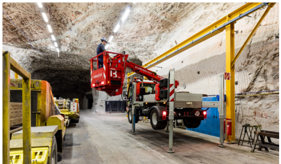
Der Unitrac 102ep 600 Meter unter Tage - im Grube Merkers in Thüringen.
